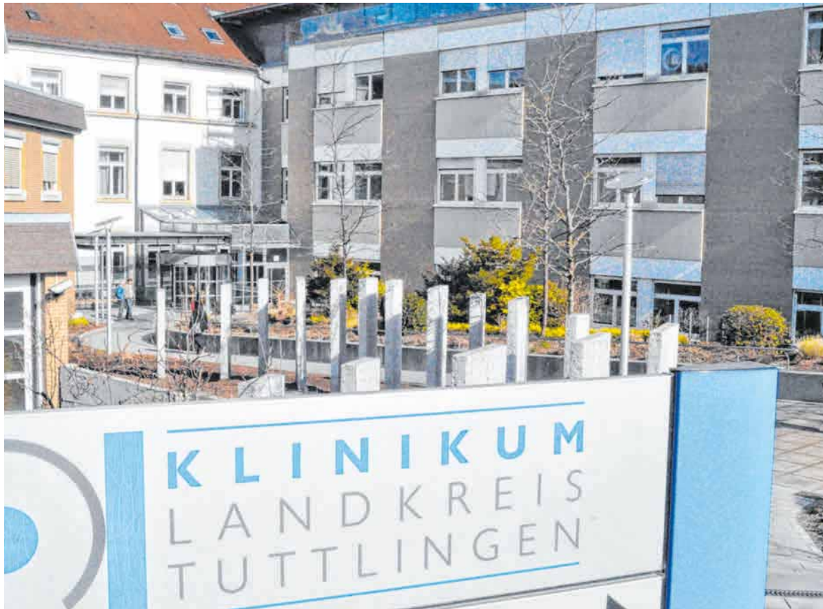
Trotz Corona-Krise, die den Haushalt des Landkreises belastet, soll das geplante Bettenhaus E sowie der Bau eines fünften OP-Saals in Angriff genommen werden. FOTO: S. GOMBERT
